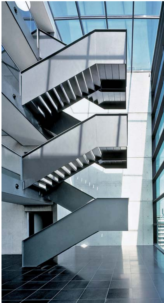
Die einheitlich graue Lackierung der Stahlteile unterstützt die skulpturale Erscheinung der Podesttreppe.
