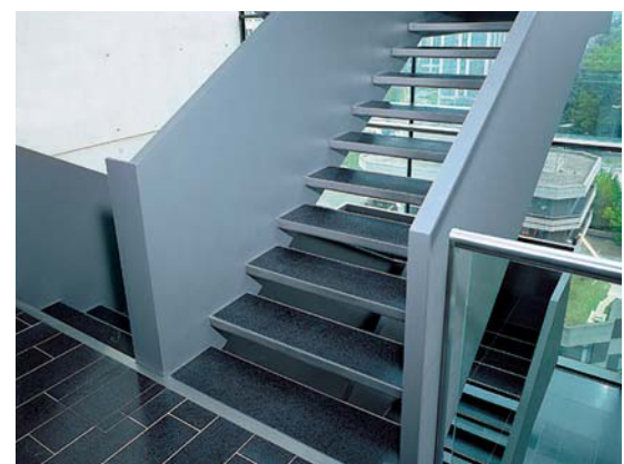
Die Trittstufen sind als Blechwannen ausgebildet mit eingelegten Steinzeugplatten.
